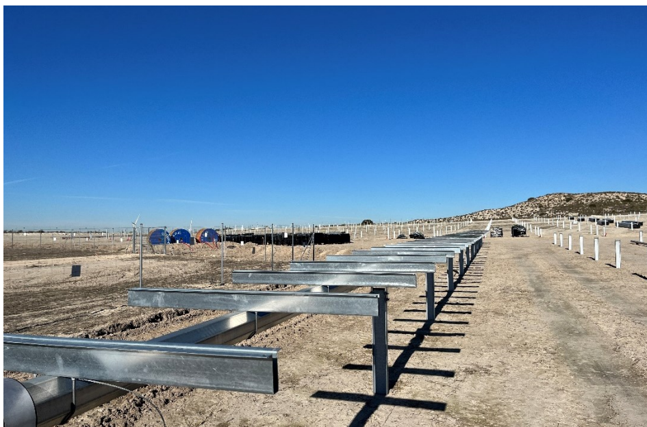
Figura 7 Montaje de los trackers
