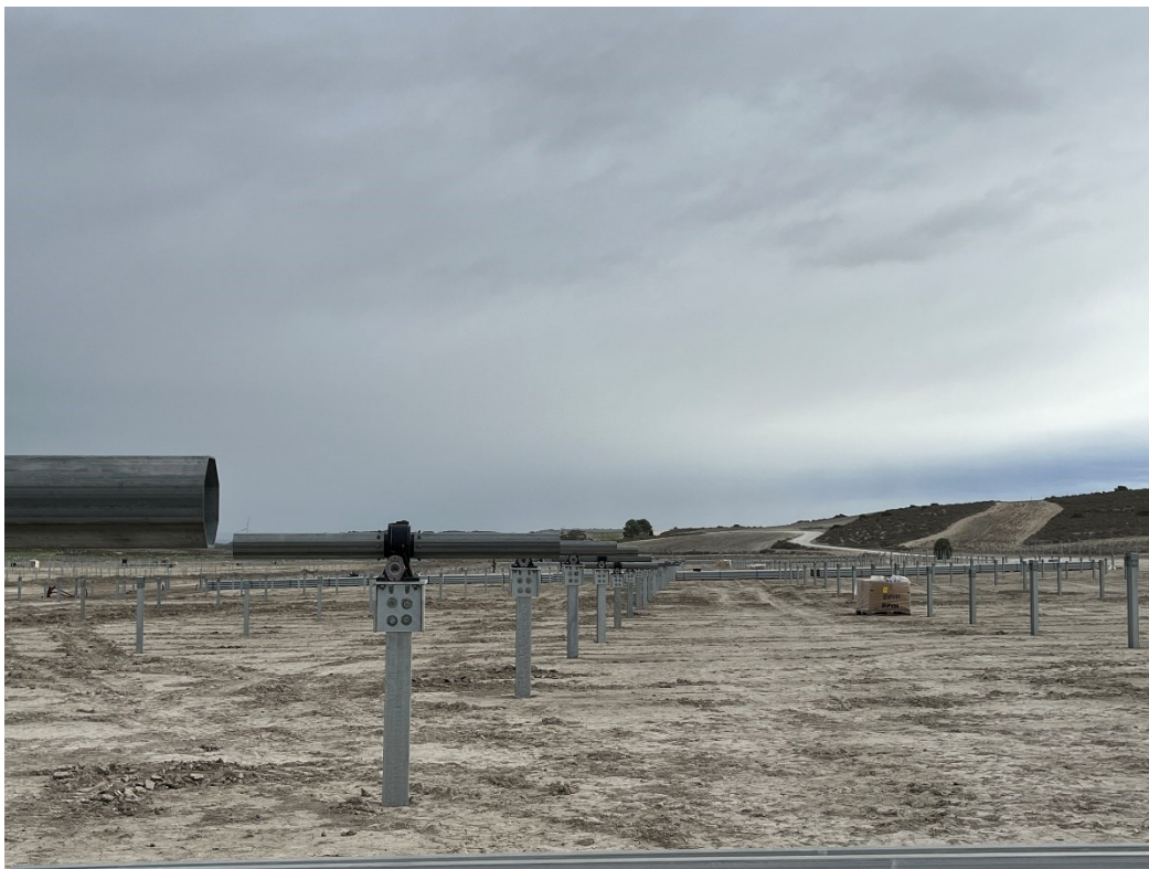
Figura 10 Montaje de las tomas de fuerza
