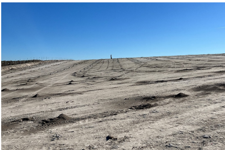
Figura 8 Perforaciones del terreno para el hincado
