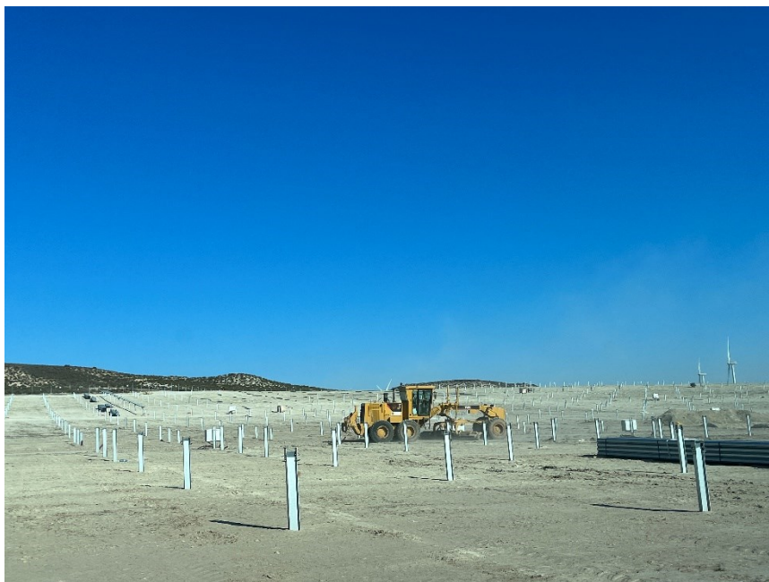
Figura 2 Nivelaciones del terreno
