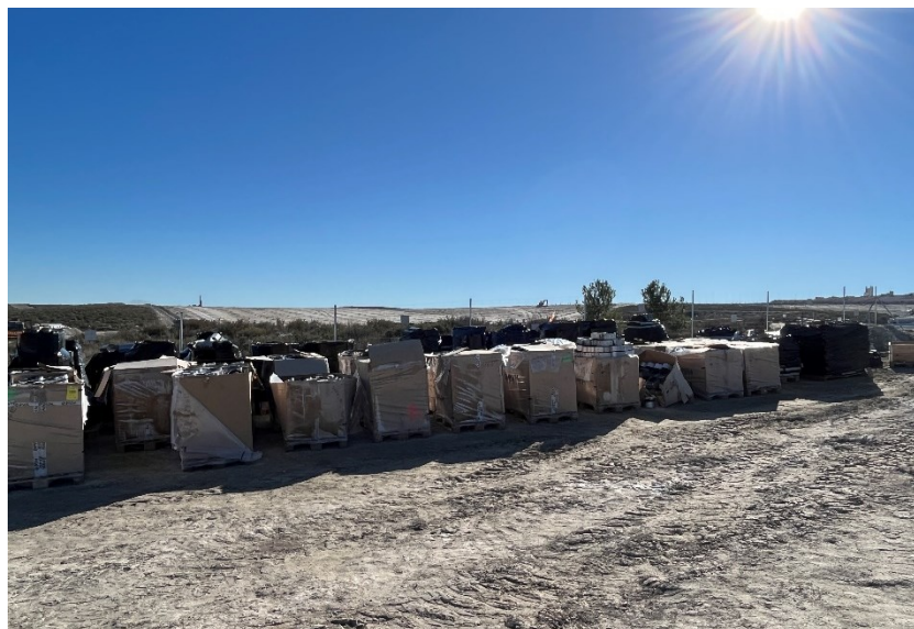
Figura 5 Zona de acopio de material de construcción
