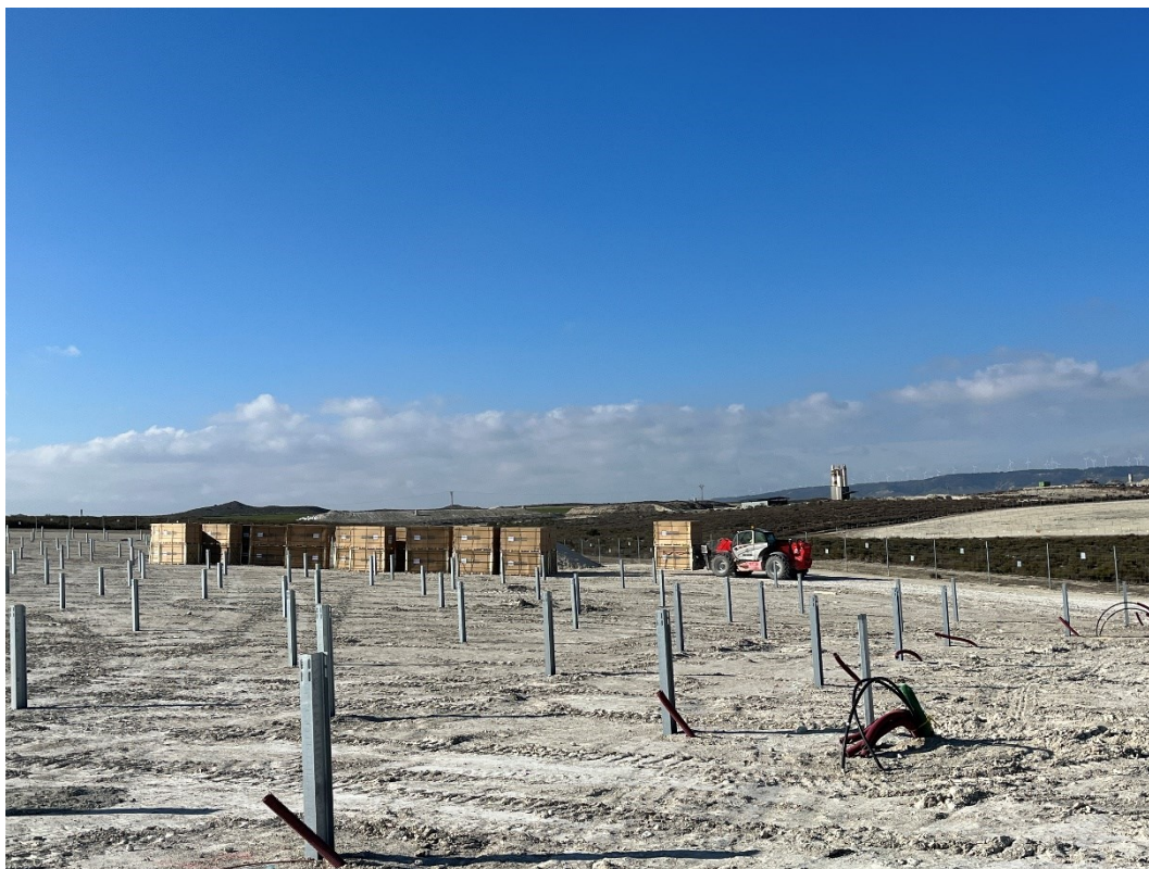
Figura 12 Acopio de los módulos fotovoltaicos
