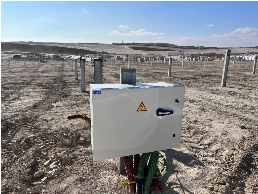
Figura 11 Montaje de los inversores
